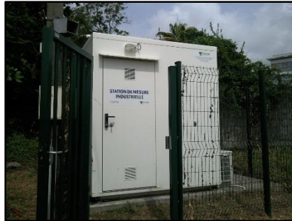
Station industrielle Etang Z'abricot
